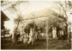
Edifice religieux converti en maison (110603_fil_066)
