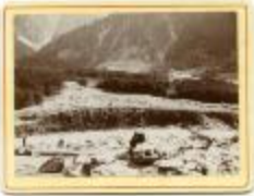
Glissement de terrain en 1905 (110609_fil_047)
