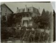
Maison à colonnade à la Croix-de-Rozon (110603_fil_064)
